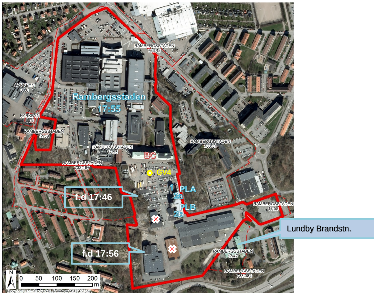
Figur 3: Flygbild över nuvarande fastighet Rambergsstaden 17:55. Byggnad BC syns i mitten av fastigheten. Även i texten refererade byggnad 1 och 2 (nuvarande PLA/PLB) är markerad. De två överkryssade byggnaderna inom södra delen revs före aktuell utredning påbörjades. Det grundvattenrör där högst vinylkloridhalter påvisats inom tidigare utredningar är markerat med gul markering (GV4).
