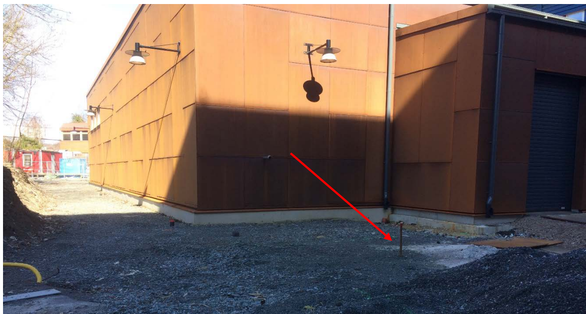
Figur 3: Fotot visa tillbyggnaden till VLU och grundvattenrör GA10 (röd pil). Fotot är taget mot nordost.
