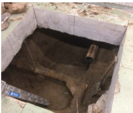
Figur 4: Uppsågat hål under verkstadsgolv (markyta) i östra delen av byggnad A. Provplats för inomhusluftmätare (golvet sattes igen med träplatta under mätperioden).
